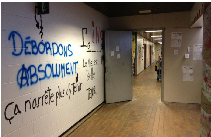
Photo : Marco Bélair-Cirino Le Devoir Les travaux visent à effacer des graffitis et d'autres dégâts au 2e étage du pavillon Hubert-Aquin.
